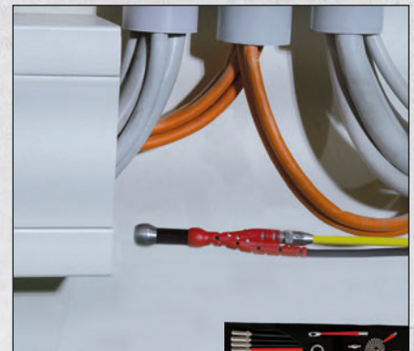
Schächte und Unterflurkanäle
